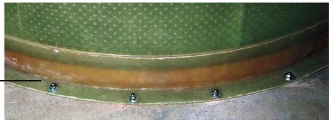
Detail: Verankerung des verstärkten Bodens im Beton
