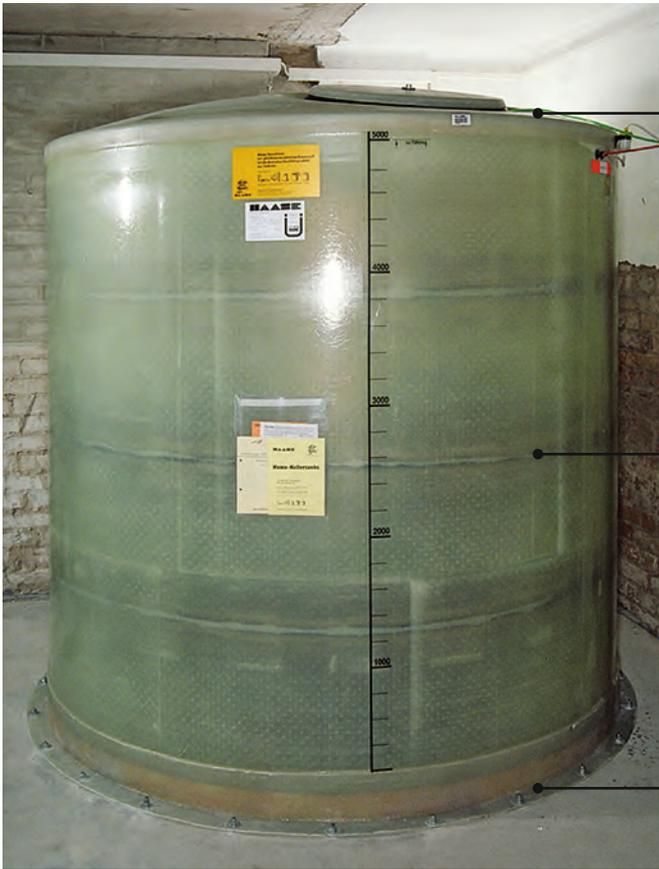
Abbildung 12: Auftriebsicherung bei standortgefertigtem GFK-Öltank
