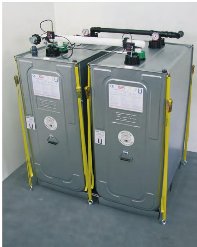
Abbildung 14: Hochwassersichere Aufstellung (Bsp. Fa. ROTH)
