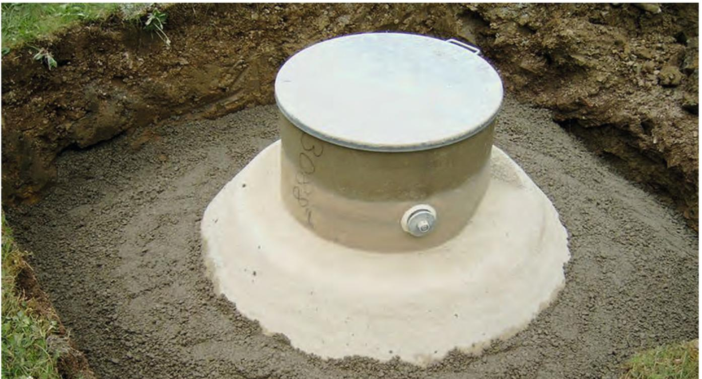
Abbildung 4: Auftriebsicherung unterirdischer Öltank (GFK-Tank)
